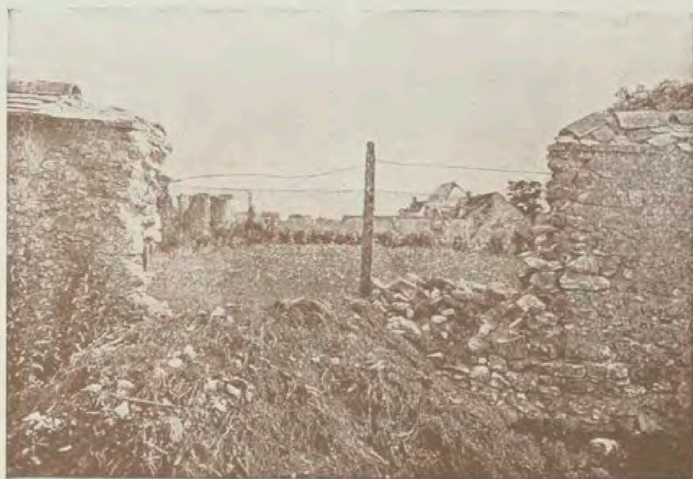
Brèche dans le mur sud du Château. (Cliché Michelin)
