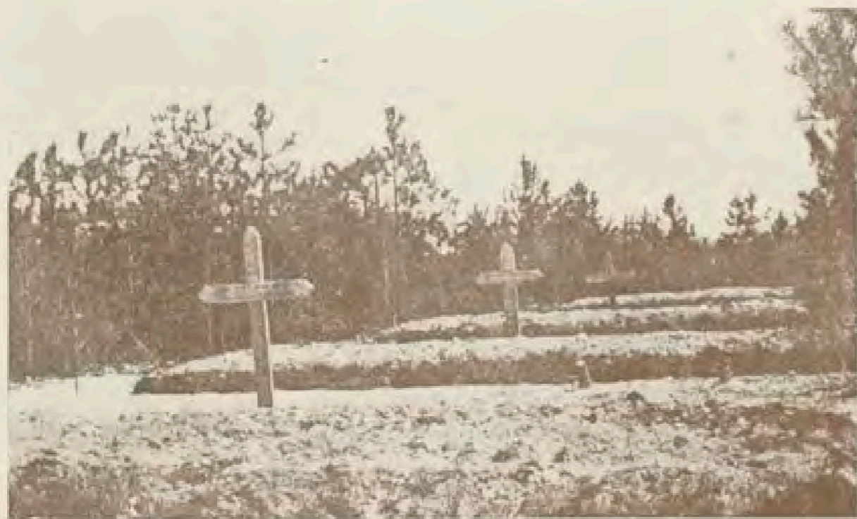
Le cimetière de la tranchée Bethmann-Holweg.
