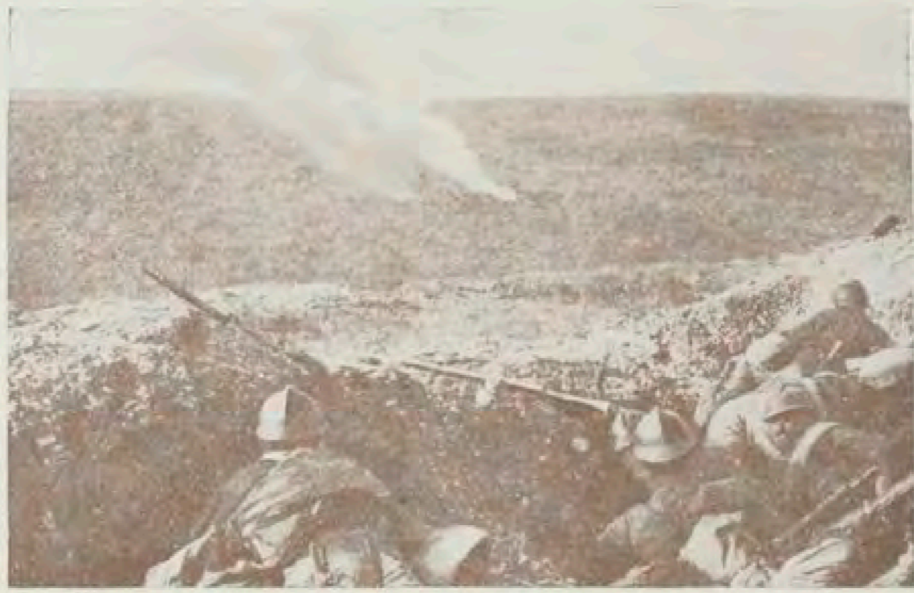
Face à l'entrée du tunnel.
