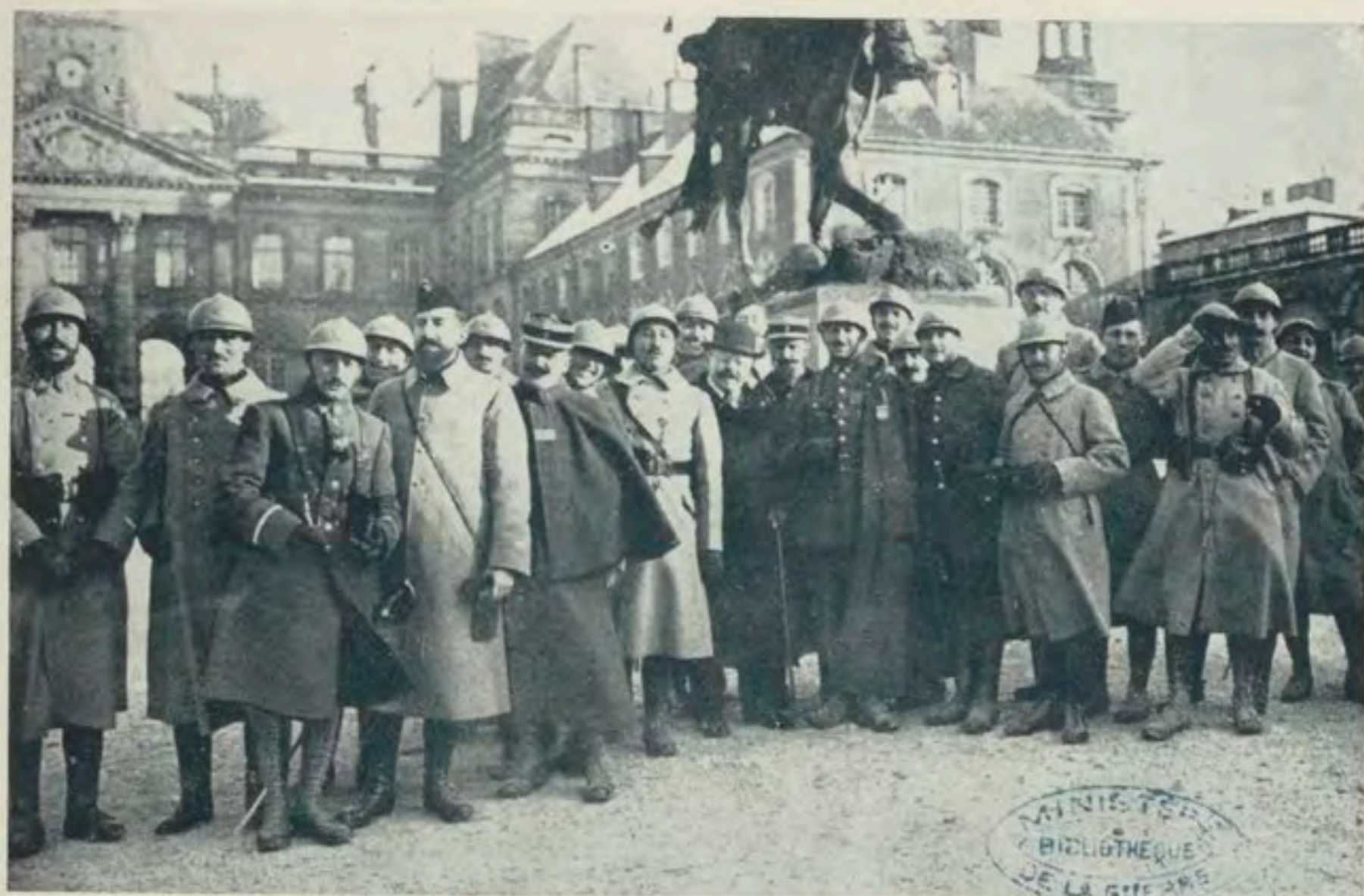
LUNÉVILLE (27 janvier 1917). — Cour du château Au centre, près du commandant Mellier, M. Keller, maire de Lunéville
